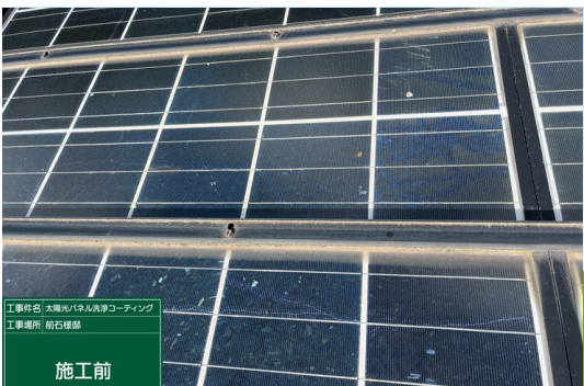
パネル一部施工前
