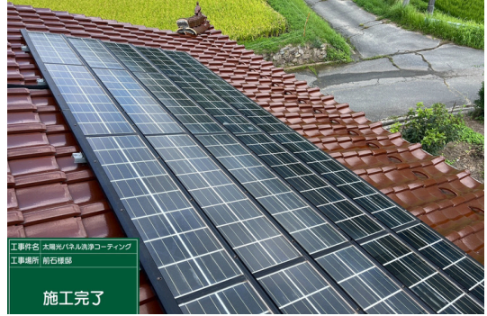
全体施工完了
