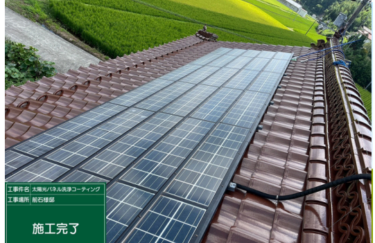
全体施工後②
