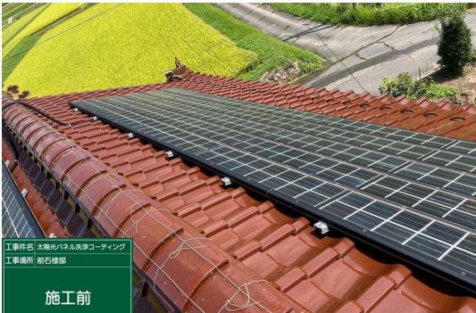
全体施工前②
