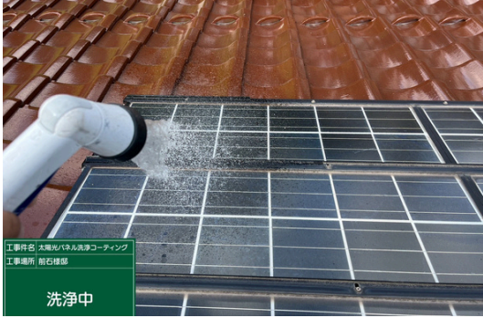
パネル洗浄中
