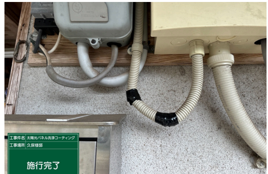
PF管補修後
