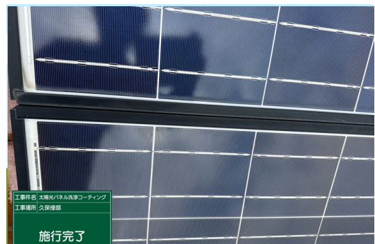
パネル施工後
