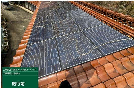
パネル施工前
