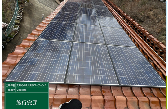
パネル施工後
