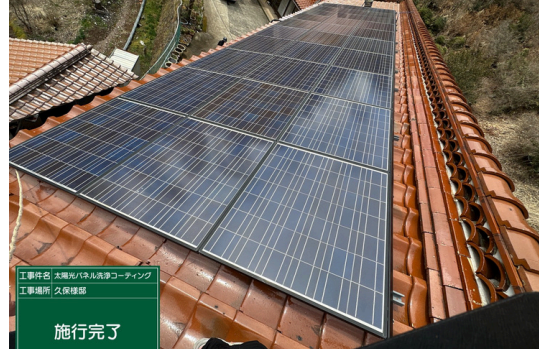
パネル施工後
