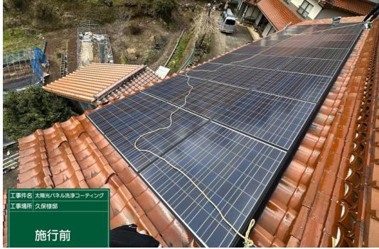
パネル施工前
