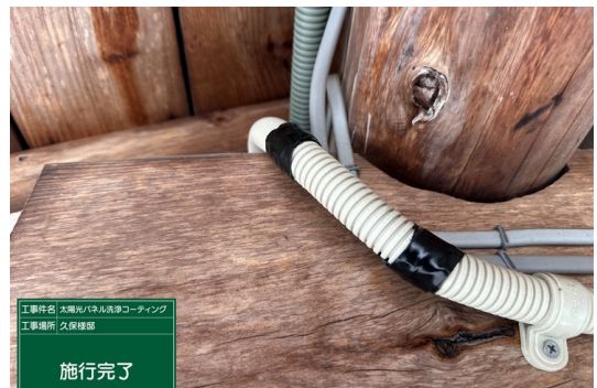
PF管補修後
