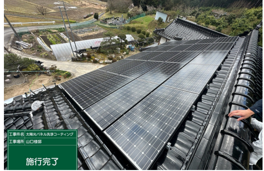
パネル施工後
