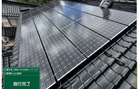
パネル施工後
