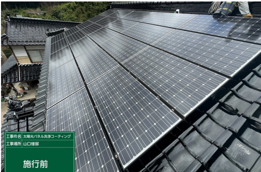
パネル施工前
