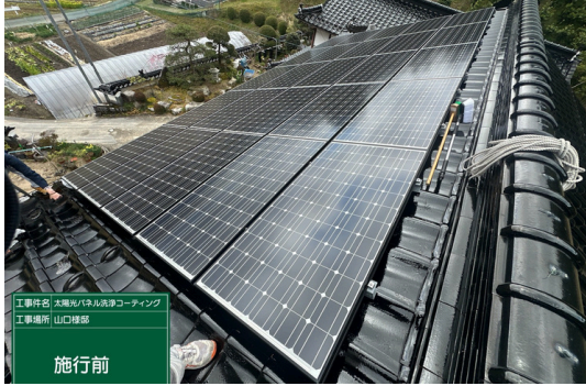
パネル施工前
