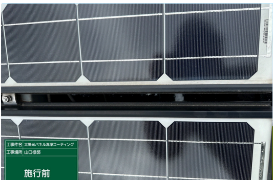
パネル施工前
