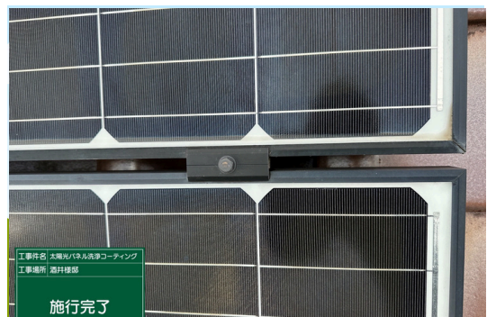
パネル施工後
