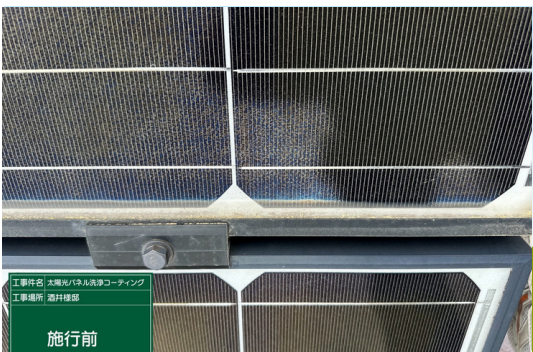
パネル施工前
