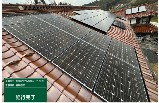
パネル施工後
