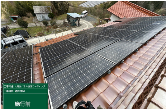
パネル施工前
