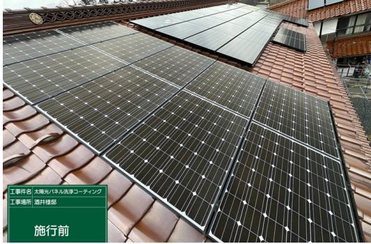
パネル施工前
