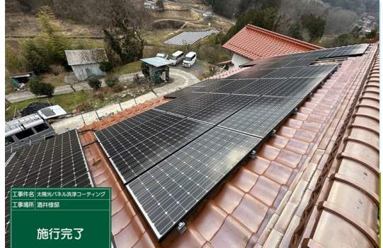
パネル施工後
