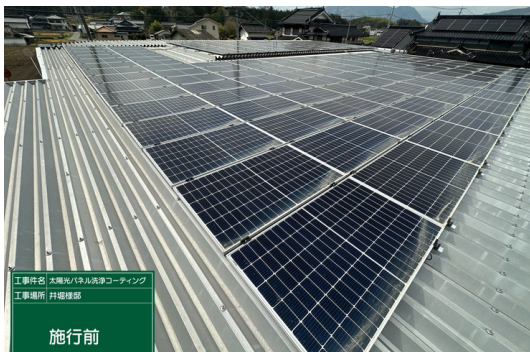
パネル施工前
