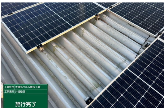
パネル撤去後
