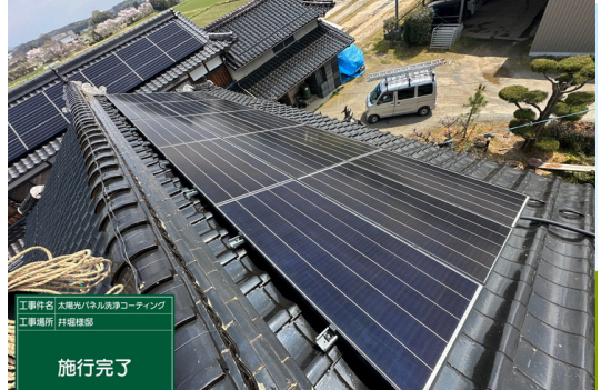
パネル施工後
