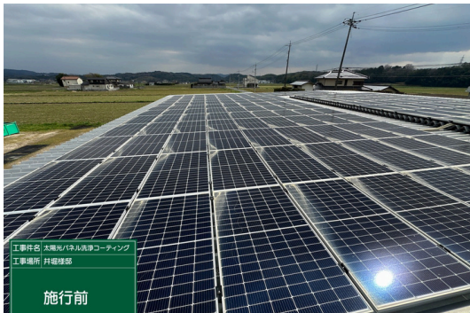
パネル施工前
