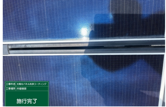
パネル施工後
