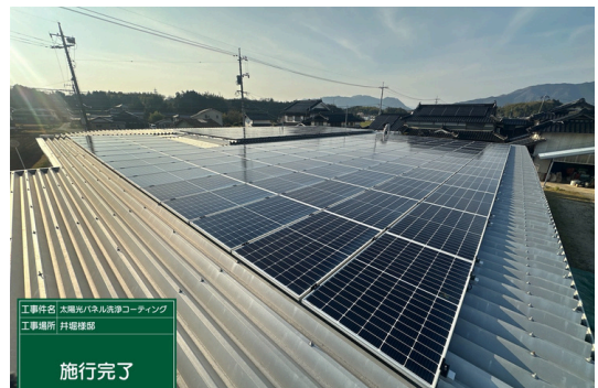
パネル施工後
