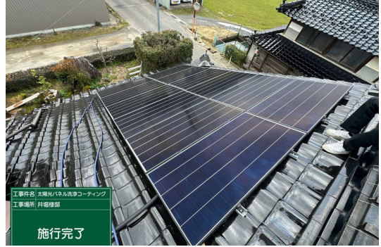
パネル施工後
