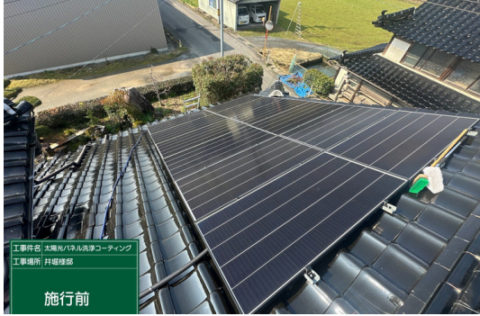
パネル施工前
