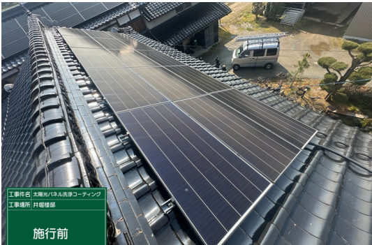
パネル施工前
