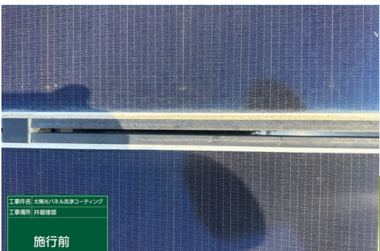
パネル施工前
