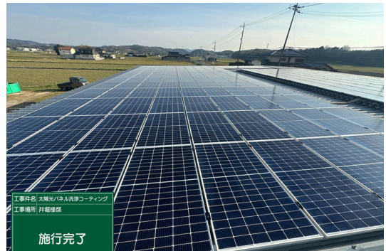
パネル施工後
