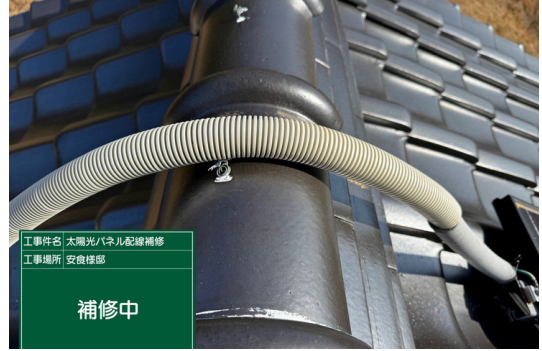
PF管補修中
