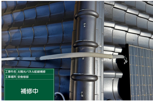
PF管補修中
