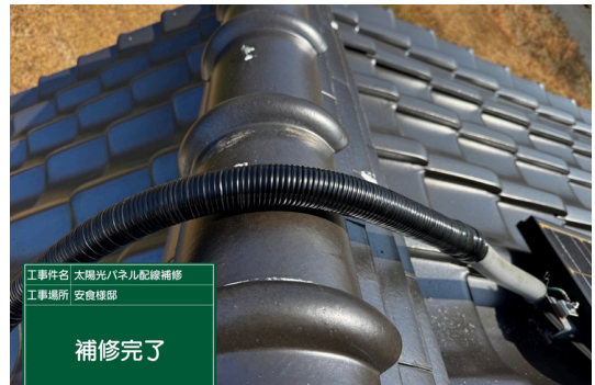
PF管補修完了
