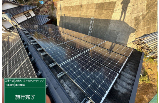
パネル施工後
