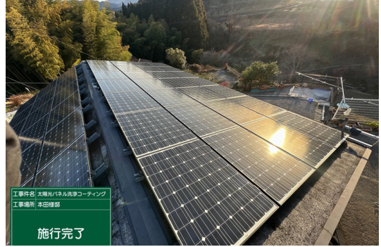
パネル施工後
