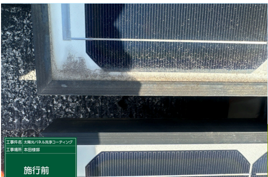
パネル施工前
