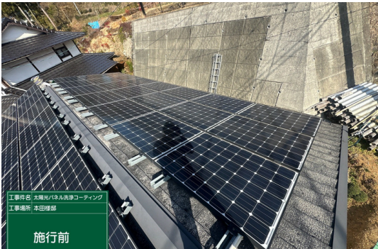
パネル施工前
