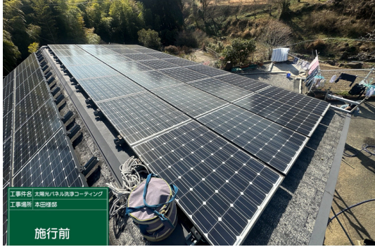
パネル施工前
