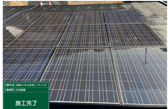
パネル施工後
