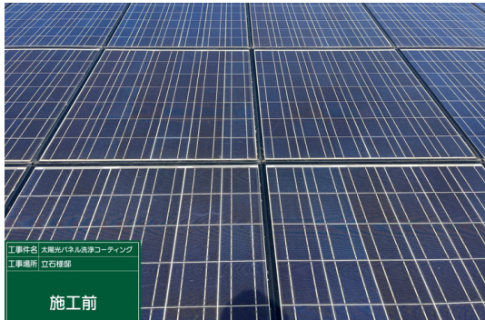
パネル施工前
