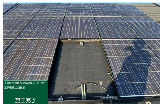
パネル撤去後
