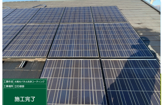
パネル施工後
