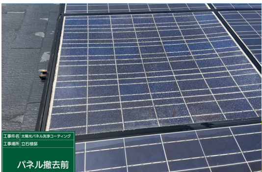
パネル撤去前
