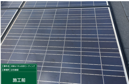
パネル施工前
