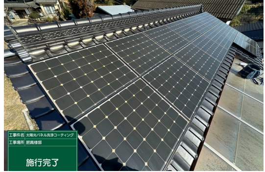
パネル施工後
