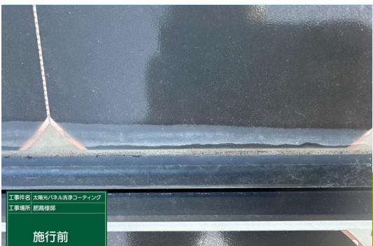
パネル施工前
