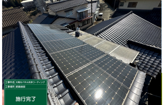
パネル施工後
