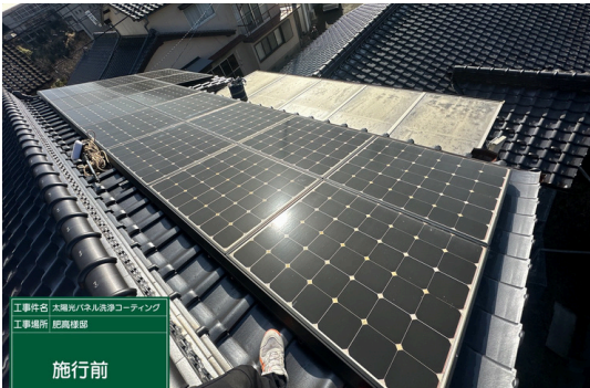
パネル施工前
