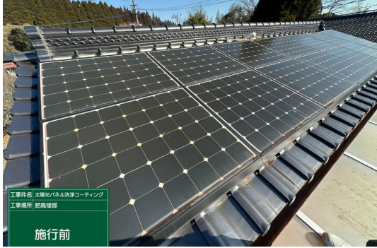
パネル施工前
