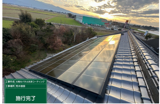
パネル施工後
