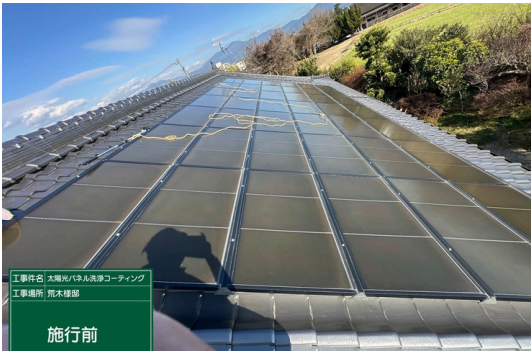
パネル施工前
