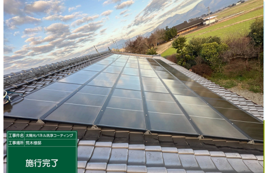
パネル施工後
