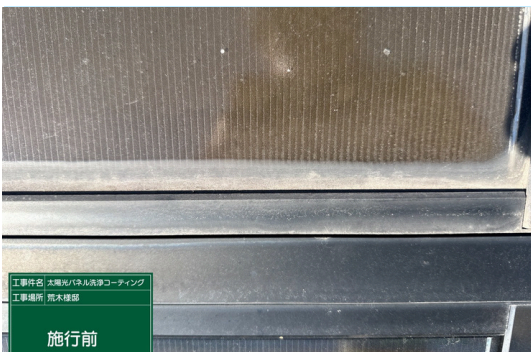
パネル施工前
