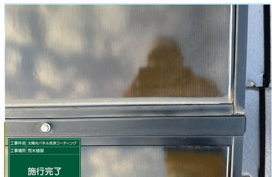
パネル施工後
