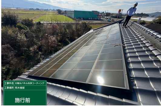
パネル施工前
