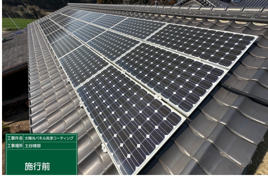
パネル施工前
