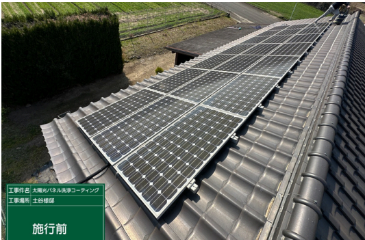
パネル施工前
