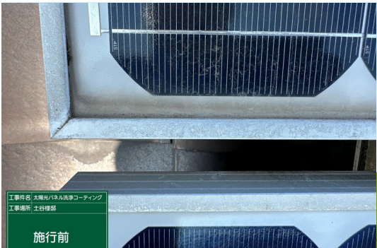
パネル施工前
