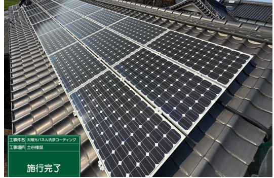
パネル施工後
