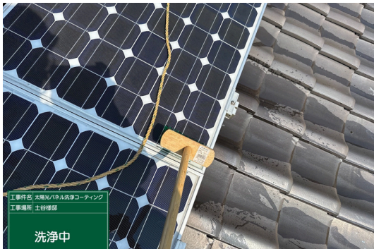
パネル洗浄中
