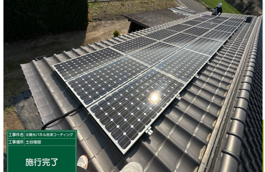
パネル施工後
