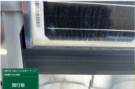
パネル施工前
