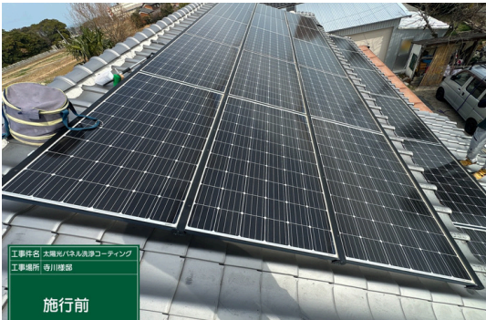
パネル施工前
