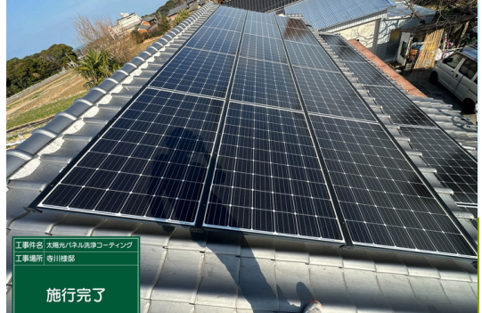
パネル施工後
