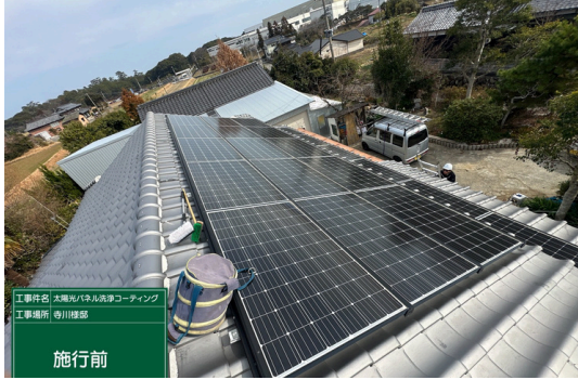
パネル施工前
