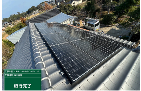
パネル施工後
