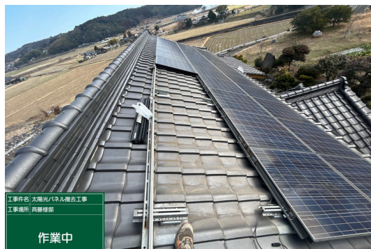
パネル撤去作業
