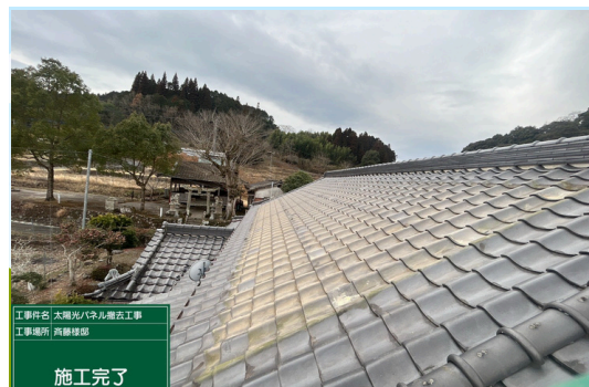
パネル撤去完了
