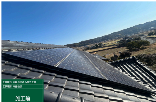
パネル撤去前
