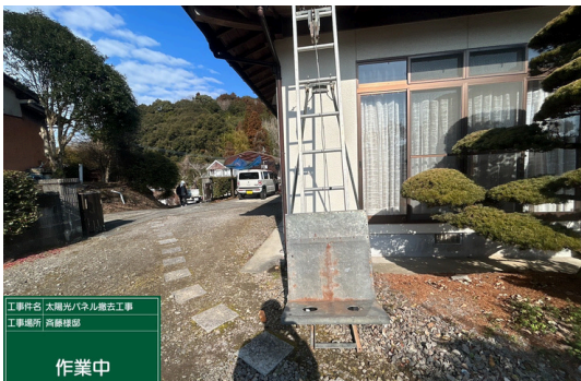
パネル撤去作業
