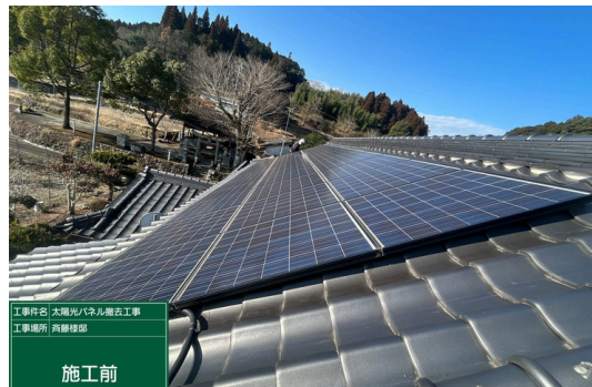
パネル撤去前
