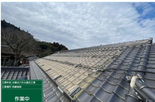
パネル撤去作業
