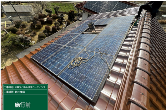
パネル施工前
