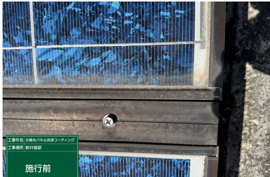
パネル施工前
