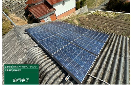
パネル施工後
