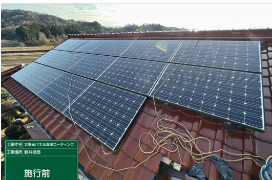
パネル施工前
