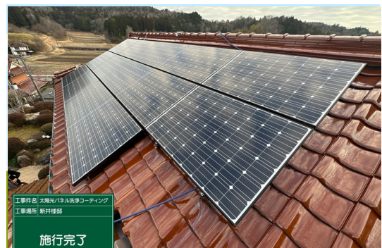
パネル施工後
