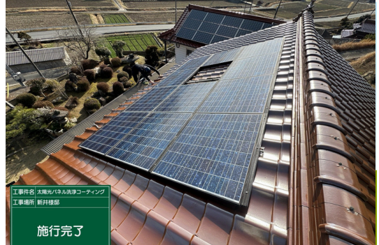
パネル施工後
