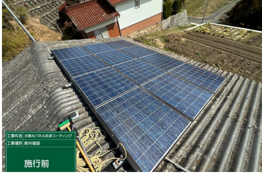
パネル施工前
