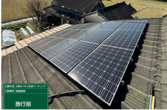
パネル施工前
