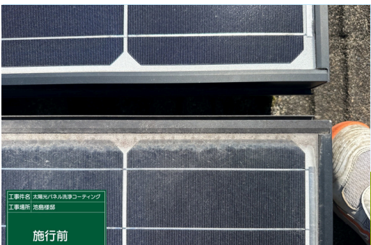
パネル施工前
