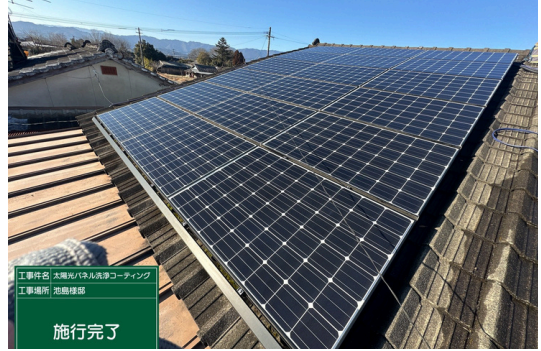
パネル施工後
