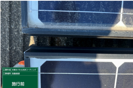
パネル施工前
