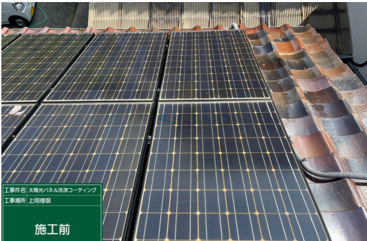
パネル一部施工前
