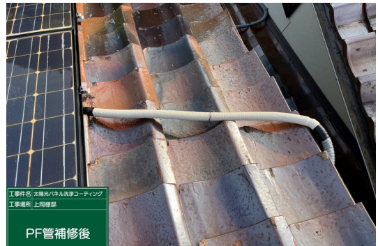
PF管補修後
