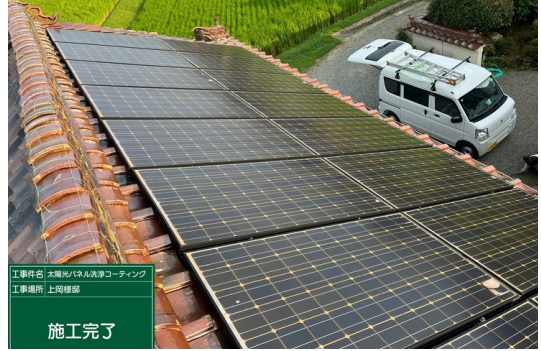
全体施工完了
