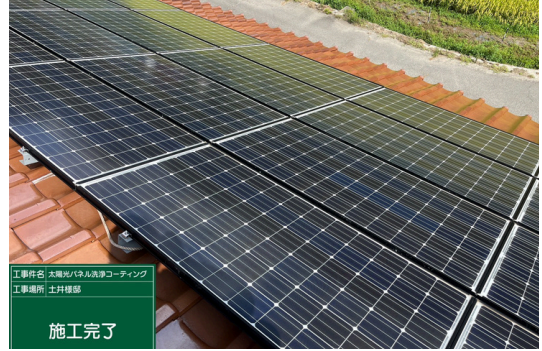
全体施工完了
