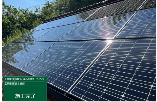
全体施工完了
