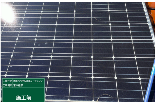
パネル一部施工前
