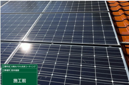
パネル一部施工前
