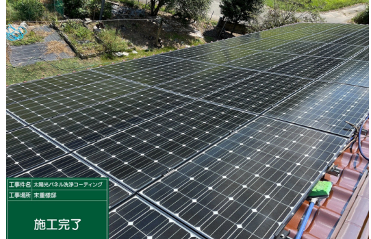
全体施工完了
