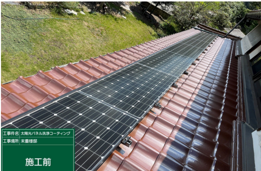
パネル全体施工前
