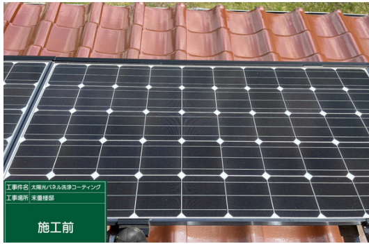
パネル一部施工前
