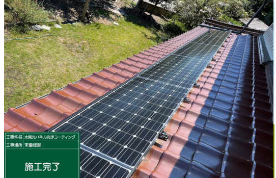
パネル全体施工後
