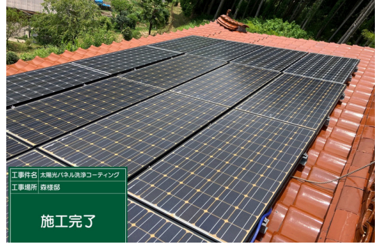
全体施工完了
