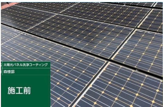
パネル一部施工前
