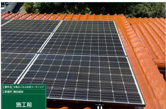
パネル一部施工前
