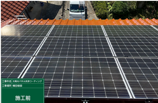
パネル一部施工前
