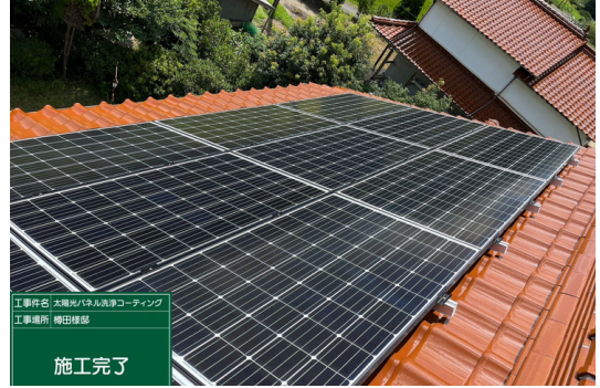
全体施工完了
