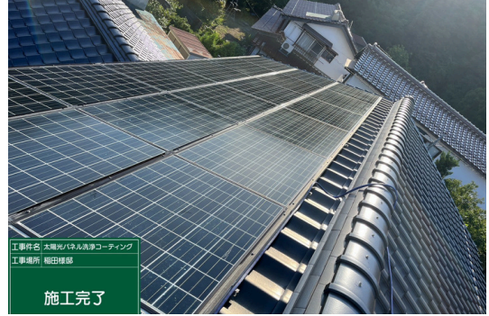
全体施工完了
