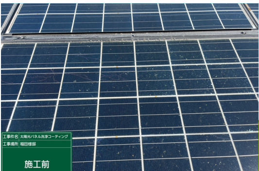
パネル一部施工前
