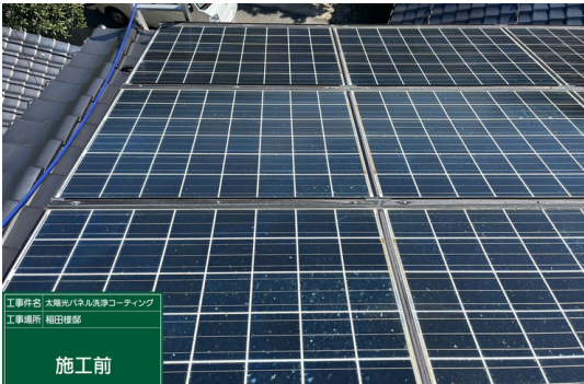
パネル一部施工前
