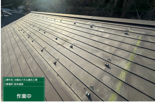
パネル撤去作業
