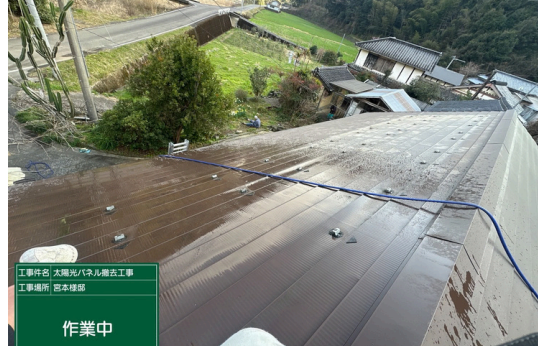
パネル撤去作業
