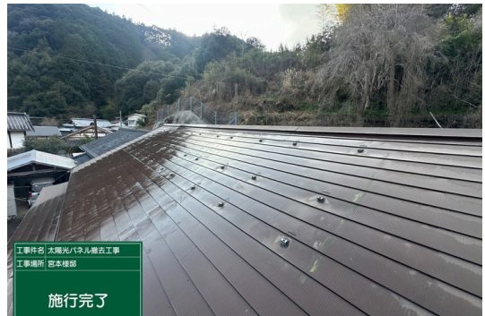
パネル撤去完了
