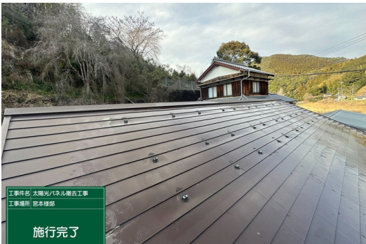
パネル撤去完了
