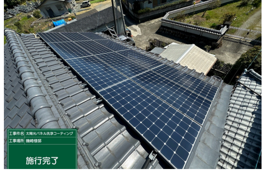
パネル施工後
