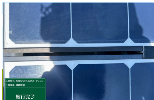
パネル施工後
