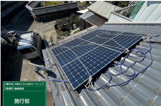
パネル施工前
