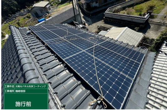
パネル施工前
