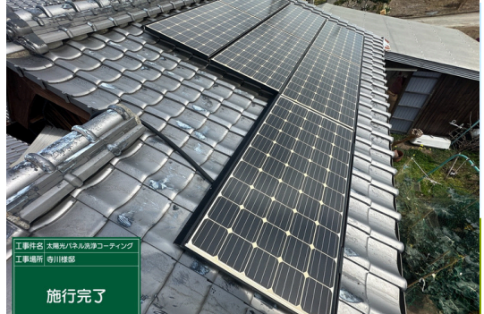
パネル施工後
