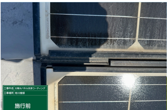
パネル施工前
