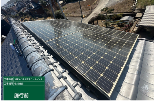
パネル施工前
