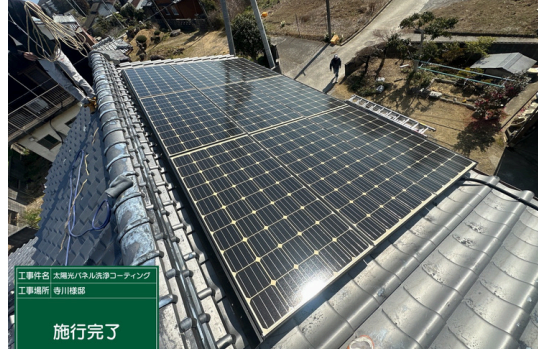
パネル施工後
