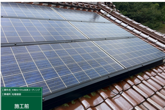
パネル施工前
