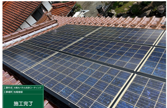
パネル施工後
