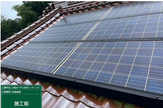
パネル施工前
