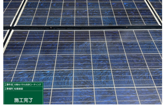
パネル施工後
