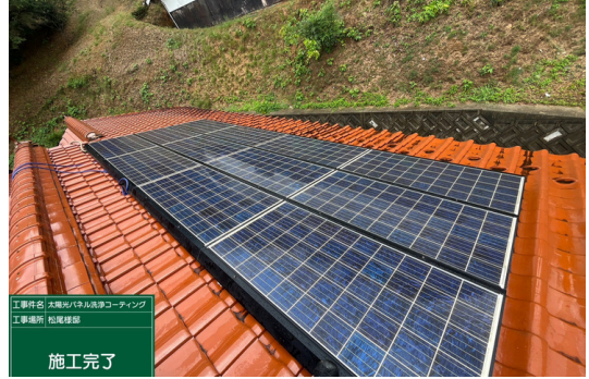
パネル施工後
