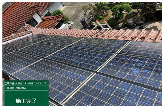
パネル施工後
