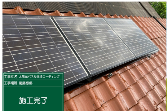
全体施工後②
