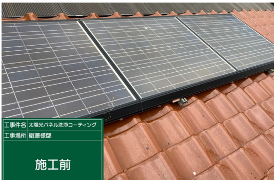
全体施工前②
